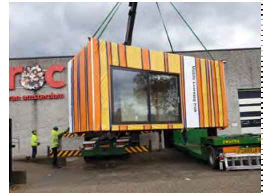
de mobiele leerunit wordt op het plein van het ROC van Amsterdam geplaatst
