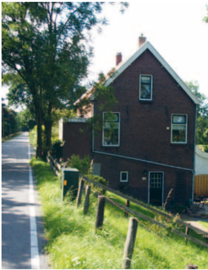
Dijkwoning uit de dertiger jaren, Poortugaal
