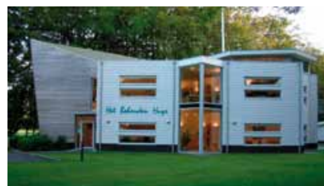
HBH Groningen: eerste gebouw van 2000
