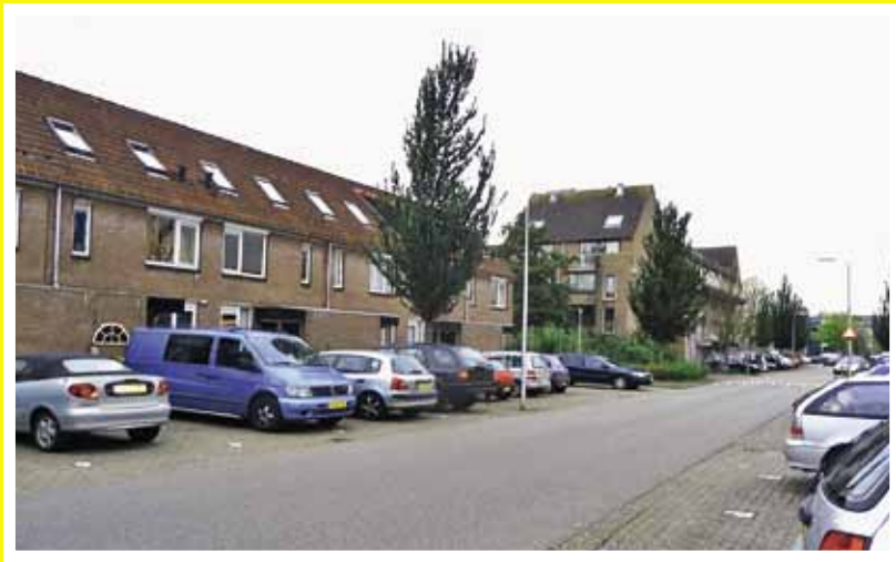
Huidige situatie bij de Blokken
