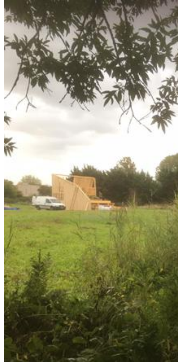
Aquaponics in aanbouw
