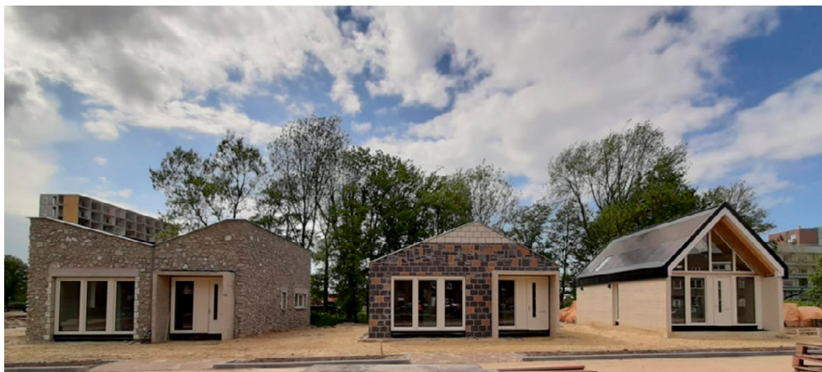
Hergebruik van delen van een bestaand flatgebouw in Kerkrade in expowoningen. Bron: 4D Architects
