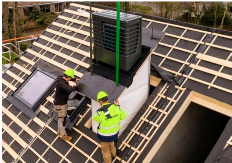
Energiemodule (geproduceerd door Factory Zero). Bron: Jan Willen van de Groep
