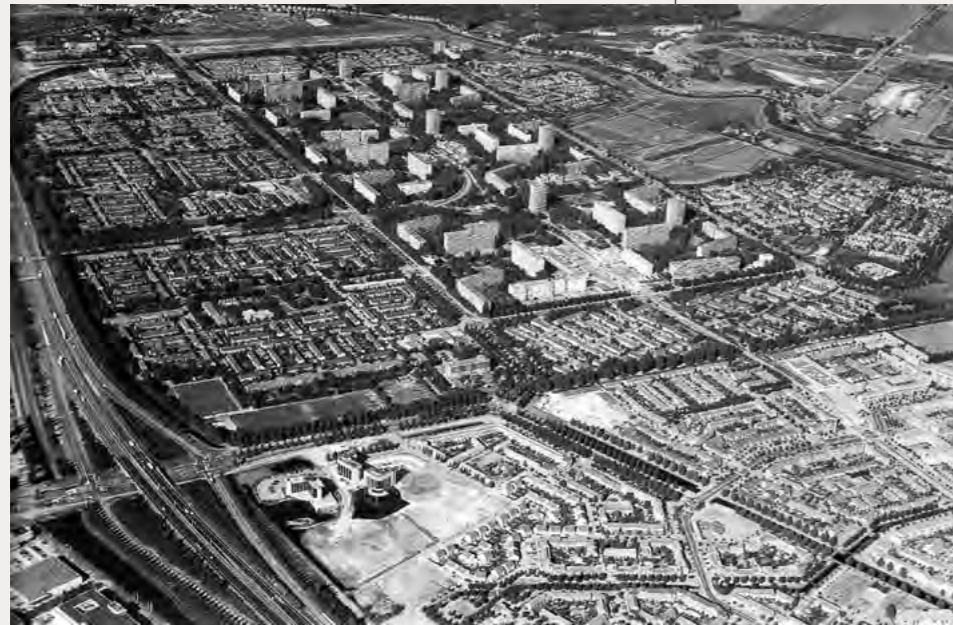
Wonen in de polder, Zevenkamp op de voorgrond in aanbouw
