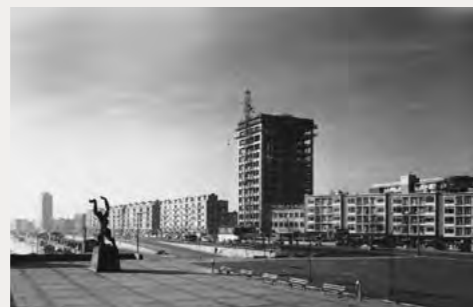
Appartementenblokken aan de Schiedamsedijk
