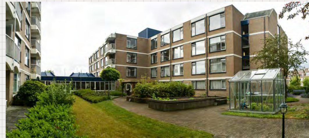
Bestaande situatie noordzijde gebouw met besloten tuin
