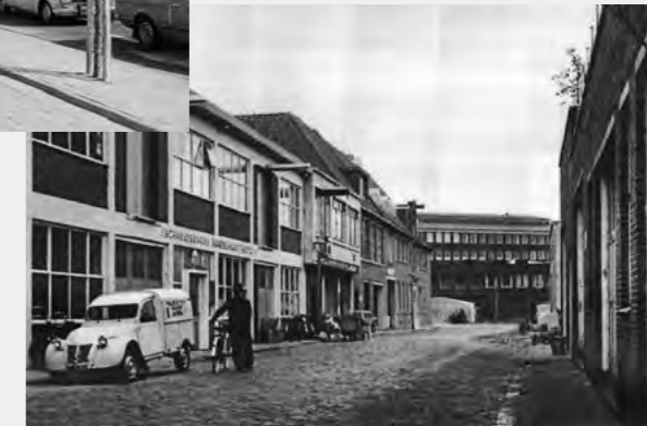
Pandsgewijze bouw aan de Hoornbrekerstraat
