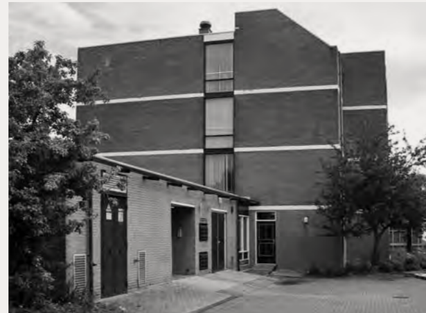
Blinde gevels aan parkeerterrein
