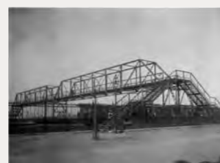
Loopbrug over het spoorwegemplacement
